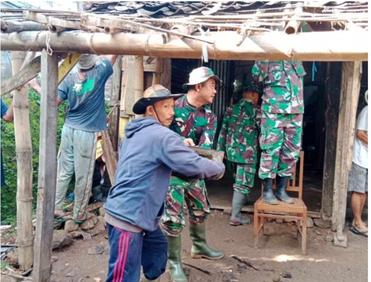
Pembongkar Rumah Sasaran RTLH
