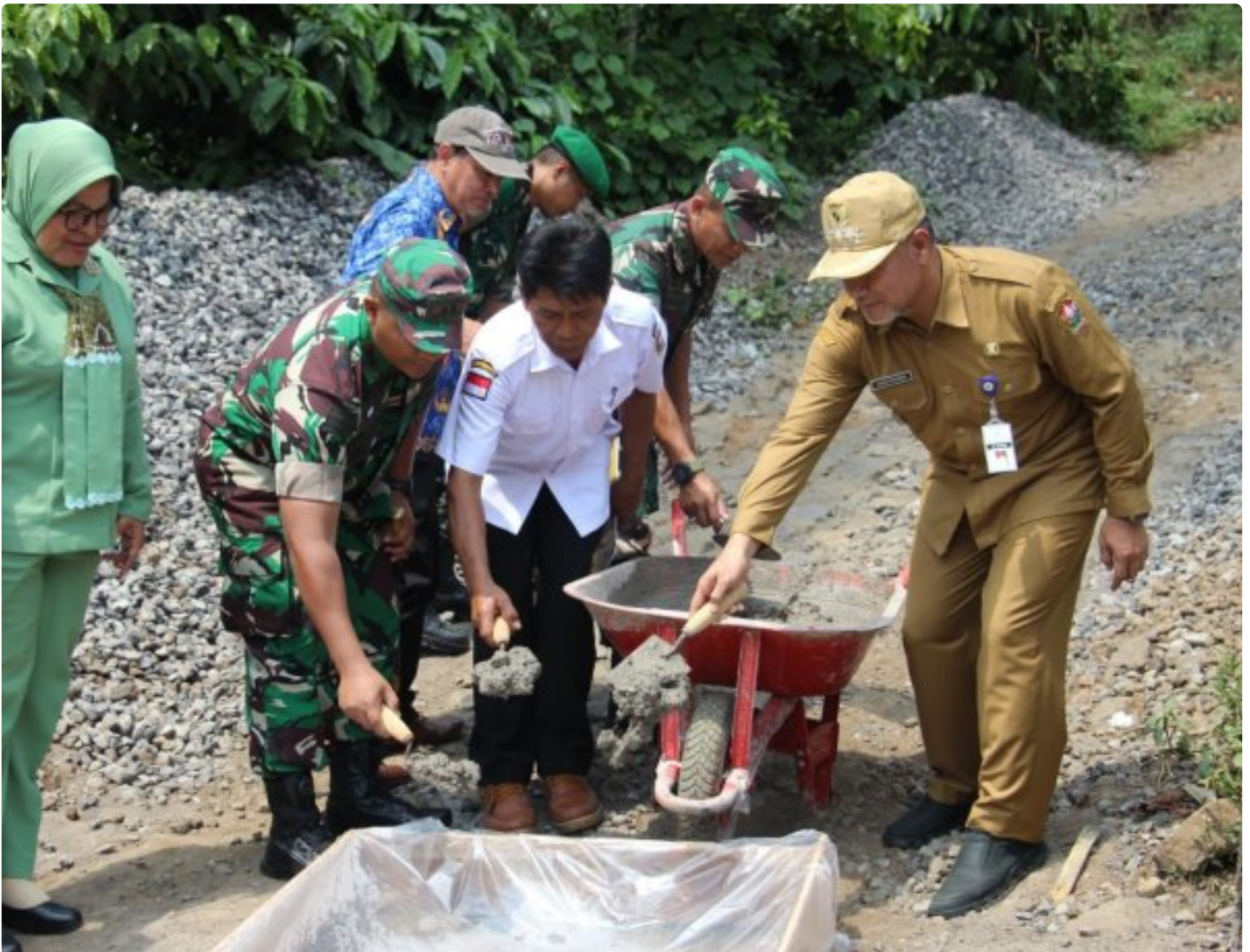
Simbolis Pengecoran Pertama Betonisasi
