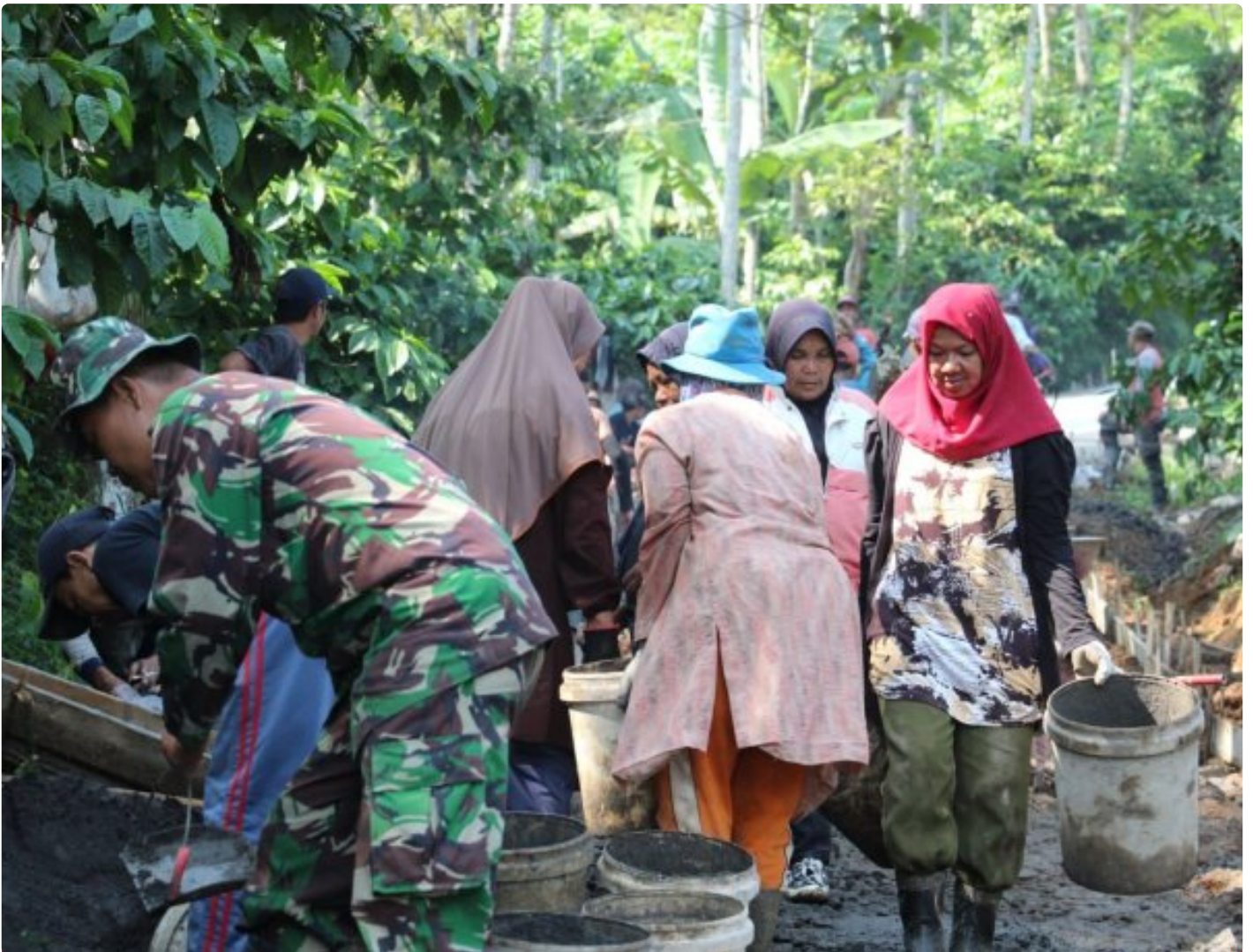
Ibu Ibu Bantu Percepat Pembangunan TMMD
