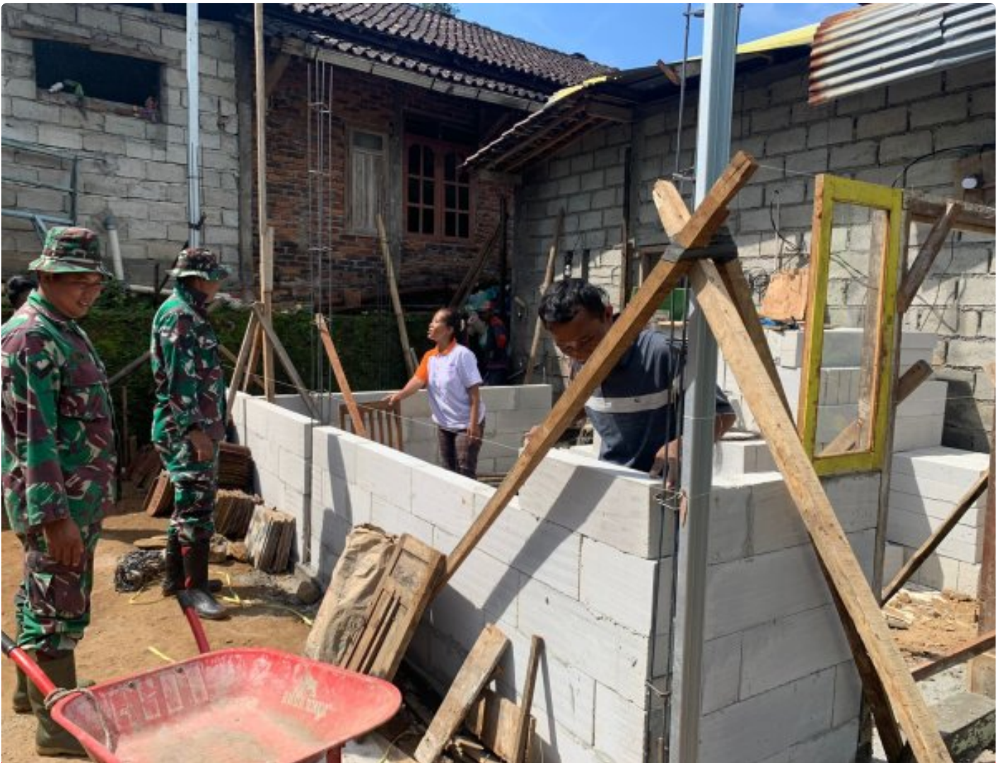
Pemasangan Dinding Menggunakan Herbel
