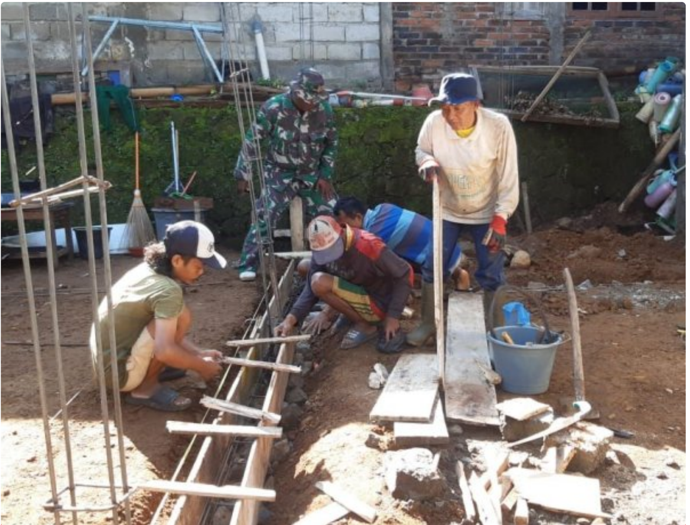
Pemasangan Bekisting Balok Sloof
