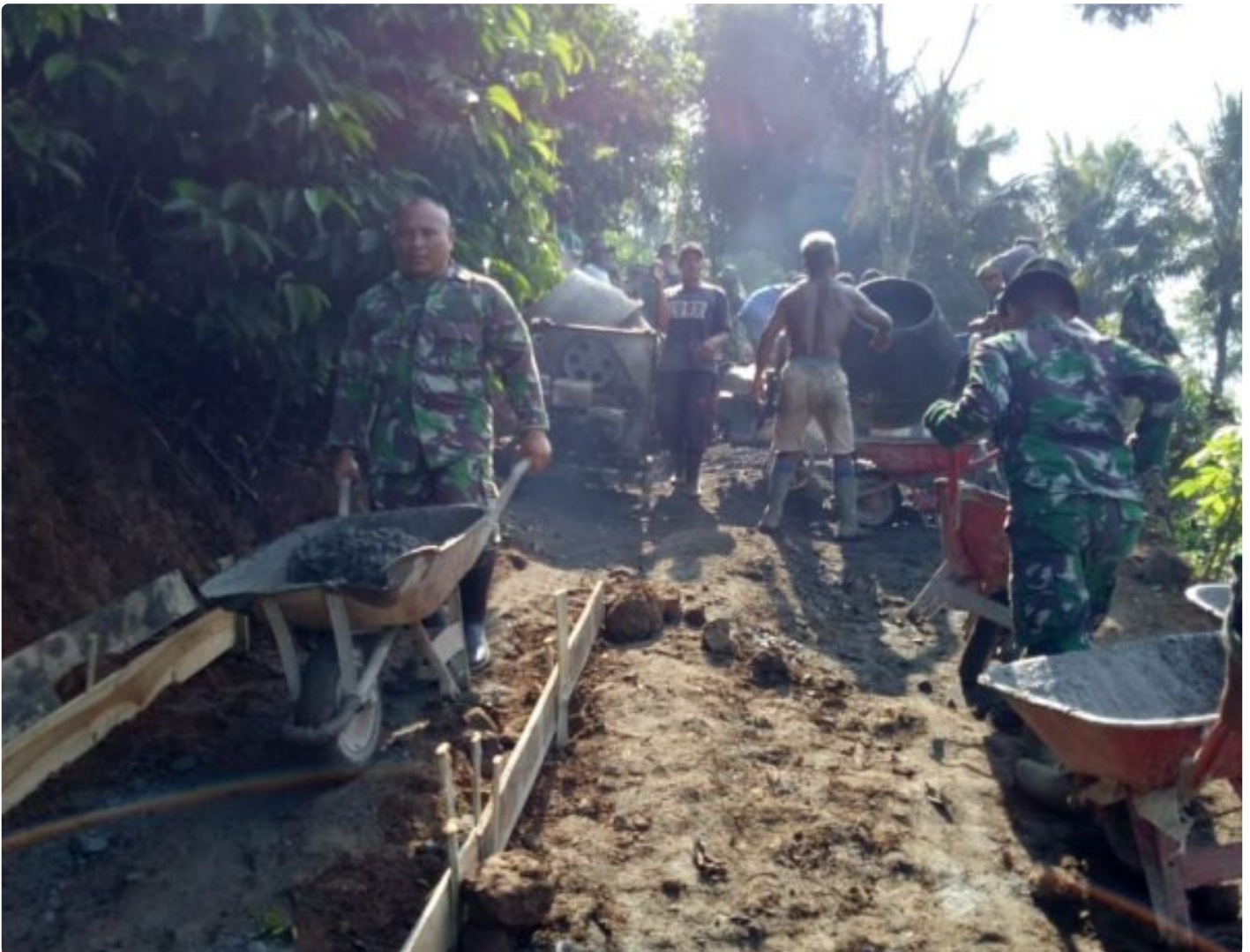
Satgas TMMD Kebut Pengecoran Jalan
